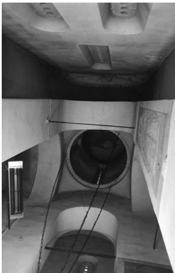
9. Церковь Рождества Богородицы на Перыни. Подкупольное пространство снизу вверх
